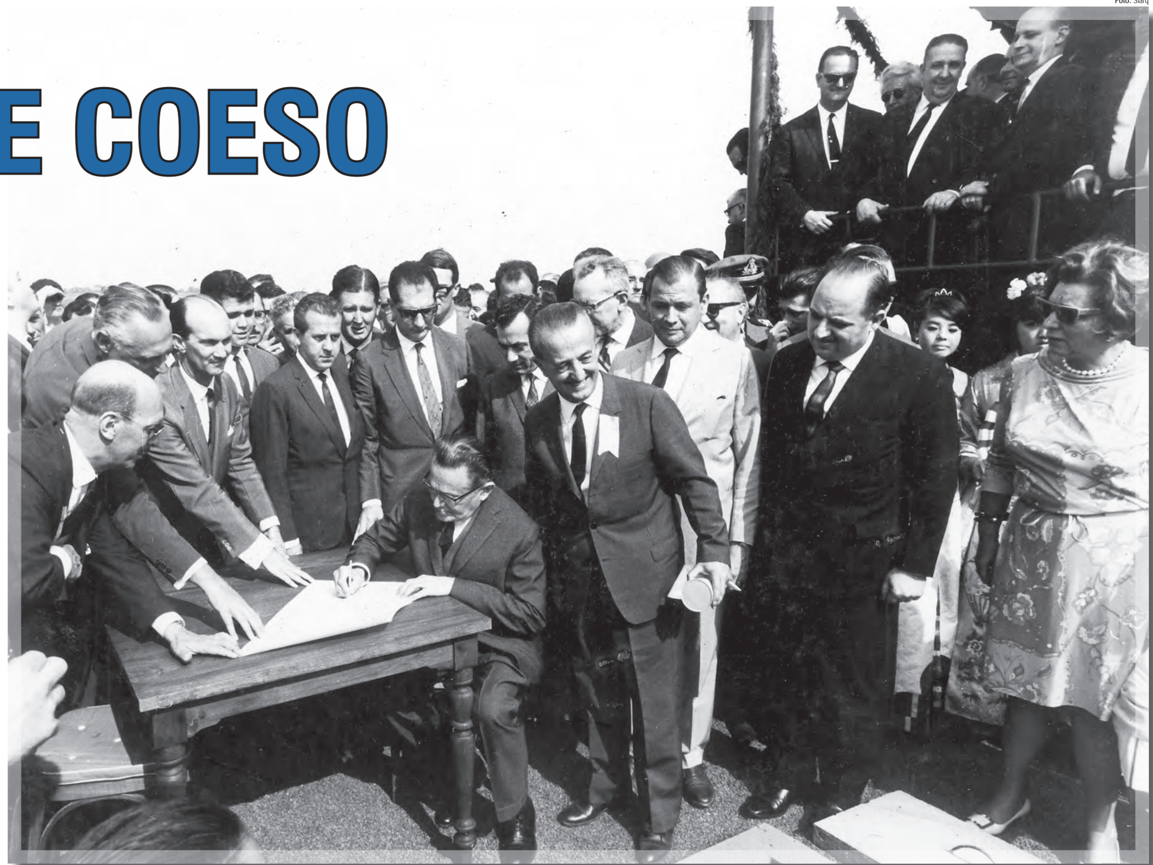
Lançamento da pedra fundamental do campus da Unicamp, em Barão Geraldo, em 5 de outubro de 1966
