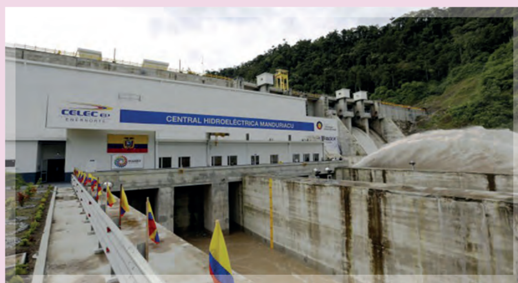
No sentido horário, o Porto de Mariel (Cuba), Aqueduto de Chaco (Argentina), hidrelétrica no Equador e a segunda ponte sobre o rio Orinoco (Venezuela)
