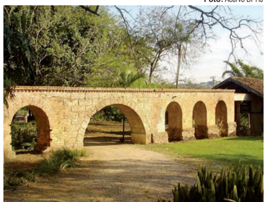
Aqueduto que trazia a água do ribeirão Camanducaia Mirim
