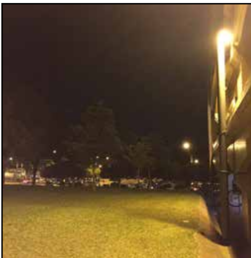
Instalação de lâmpadas e refletores nas laterais e fundos da BCCL
