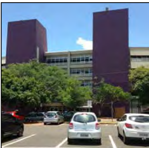
Torres da BCCL após a pintura
