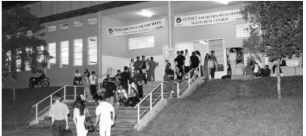
Fachada do Ceset, que funciona em Limeira: três anos de investimentos
