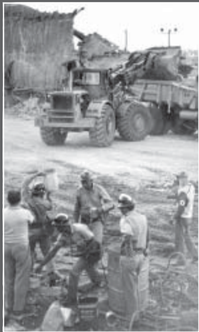
o concreto, falta de fiscalização e técnicas inadequadas para a retirada do escoramento da laje foram as causas do desmoronamento
