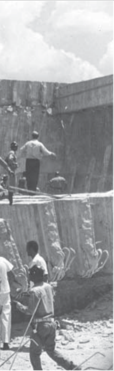
o concreto, falta de fiscalização e técnicas inadequadas para a retirada do escoramento da laje foram as causas do desmoronamento
