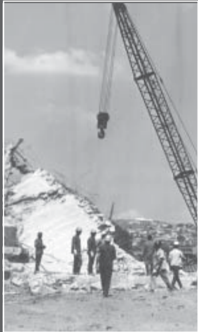
o concreto, falta de fiscalização e técnicas inadequadas para a retirada do escoramento da laje foram as causas do desmoronamento
