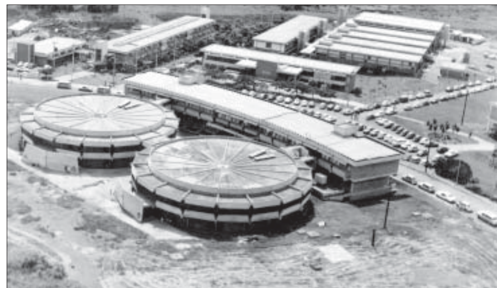
Aspecto da área central do campus em meados da década de 70, com o Ciclo Básico em primeiro plano
