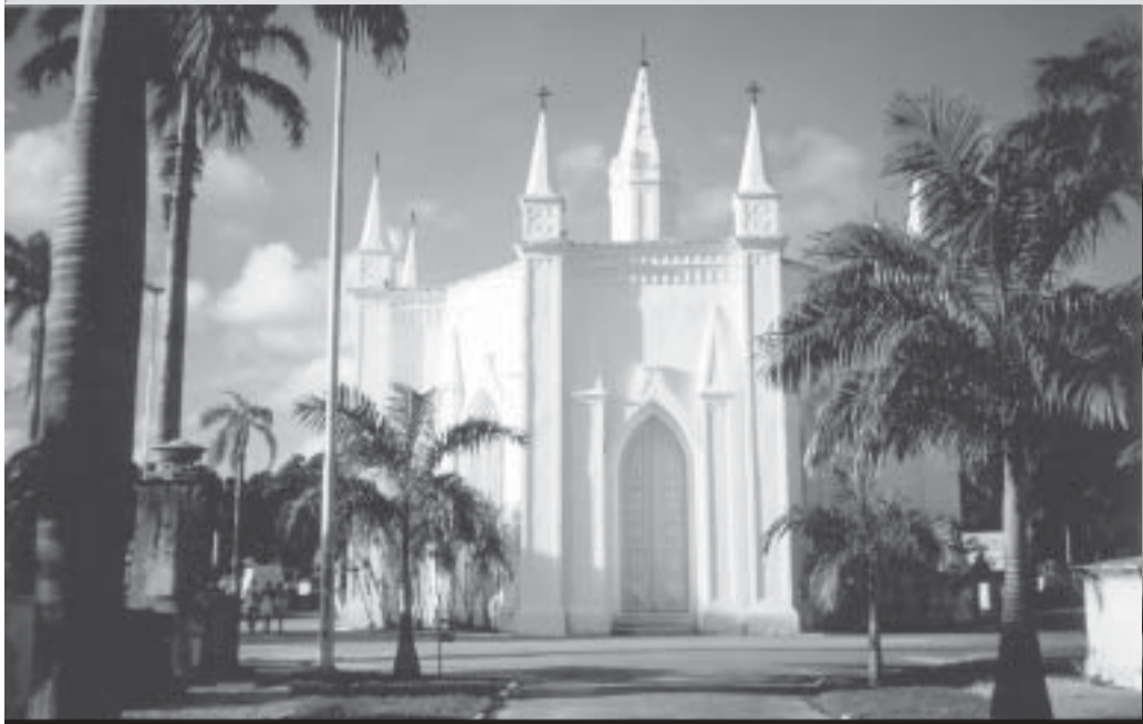
Vista da Capela do Bom Jesus da Redenção, no Cemitério Público do Recife: primeira necrópole projetada com capela no país
