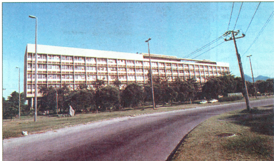
Fachada de unidade da UFRJ, no campus do Fundão, no Rio de Janeiro
