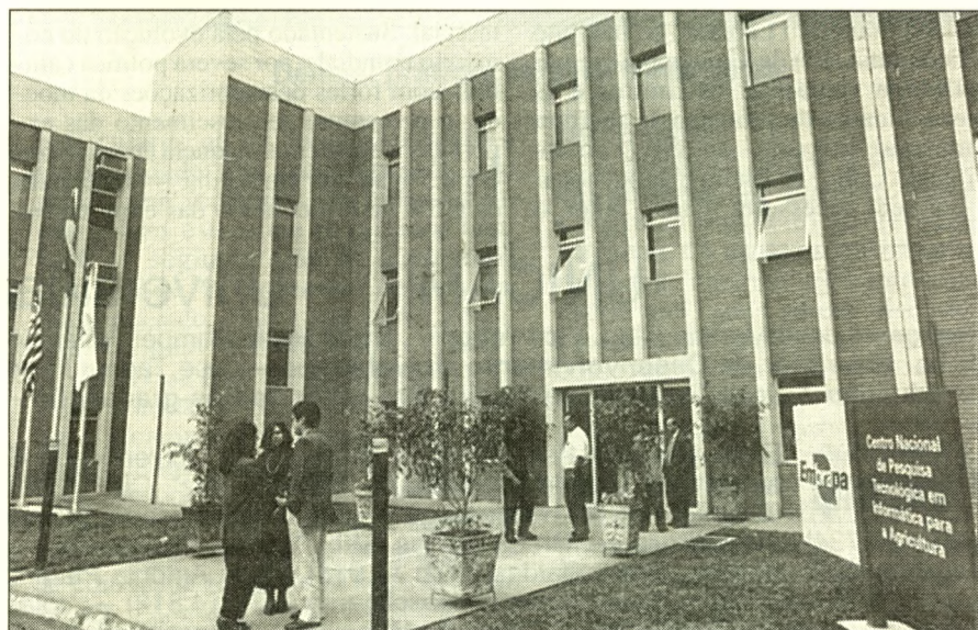
Prédio-sede do CNPTIA no campus da Unicamp.
