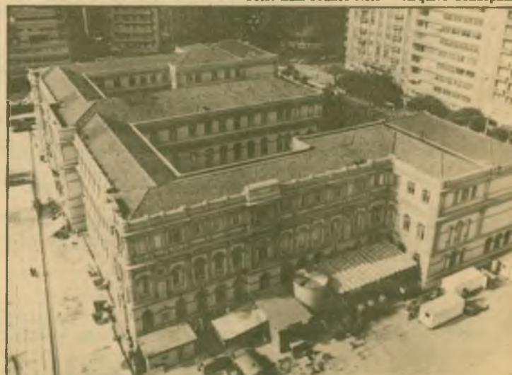
Colégio Caetano de Campos, em São Paulo: preservação.
