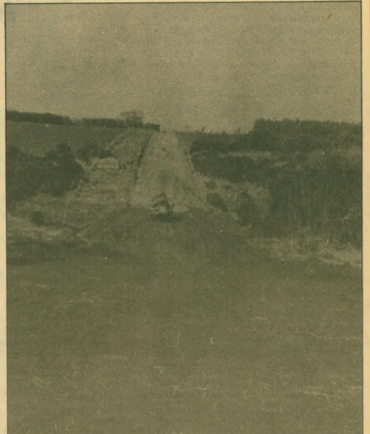
A avenida de acesso à Unicamp em construção.
