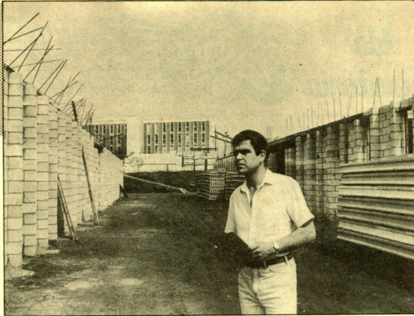
Antonio Celso, o diretor, inspeciona o canteiro da nova Engenharia Mecânica.
