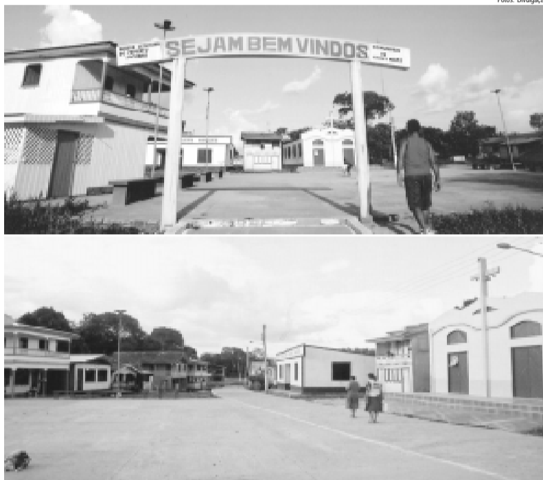
Vista de Arixi, no Estado de Amazonas: gerador a diesel abastece parcialmente o vilarejo
