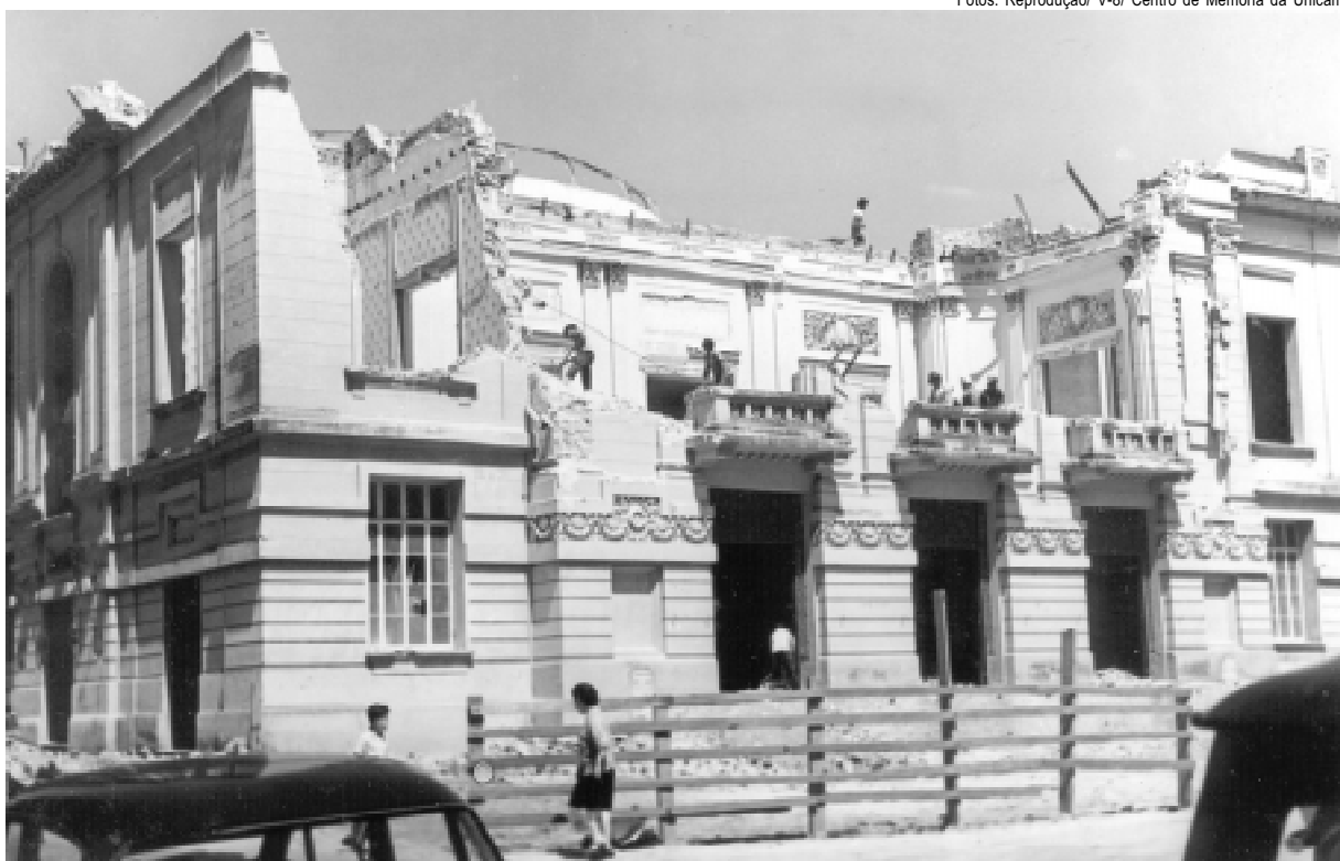
Demolição do teatro, acompanhada pelo fotógrafo V-8: polêmica
