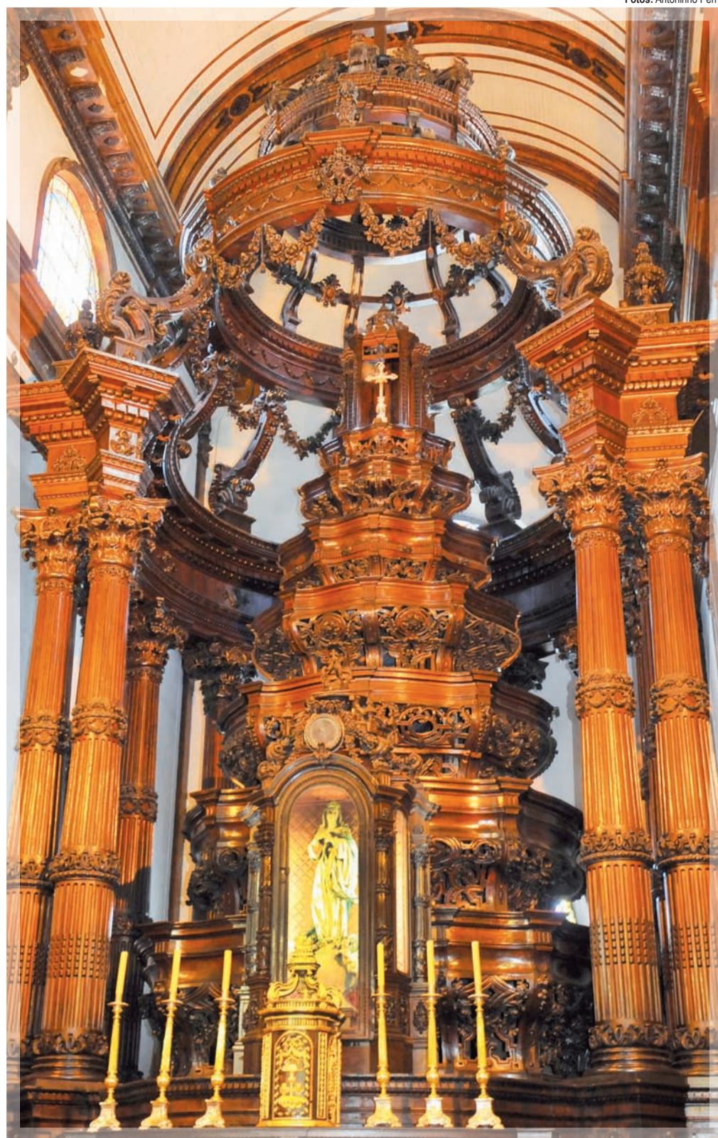
Detalhe da talha da igreja: obra mais importante do templo, em torno da qual o projeto de construção foi executado
