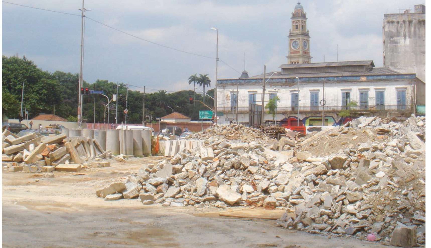
Quarteirão demolido em 2008, no âmbito do projeto Nova Luz, nas confluências das ruas General Couto de Magalhães, dos Gusmões e Mauá, no Centro de SP: impasse
